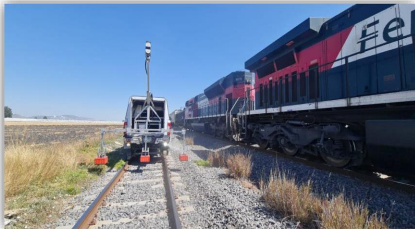
INSPECCIÓN GPR, LIDAR Y FOTOGRAFÍAS
